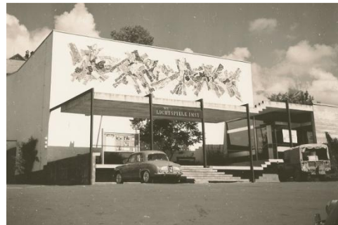
Errichtung des Stadtkinos in Imst.
